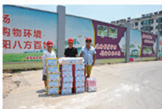
溧阳市清溪菜场土建项目现场
