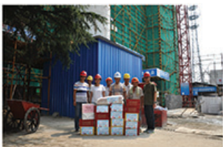
武进区礼河实验学校项目现场
