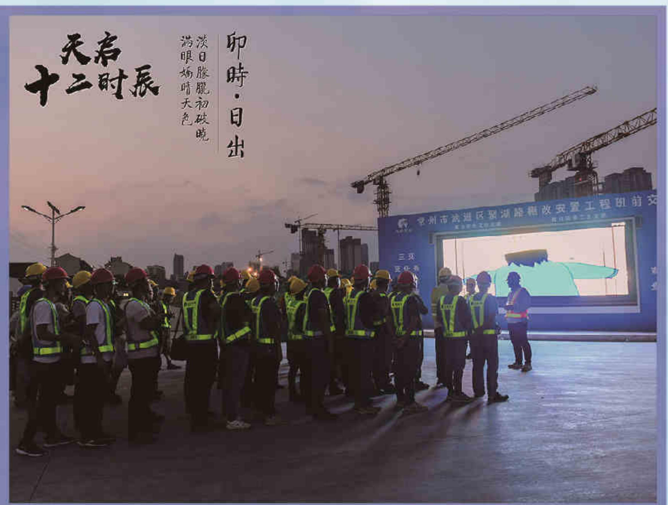
晨光微露，朝霞满天，班前交底“如约而至”，安全第一，开足马力，全心投入一天的战斗。
