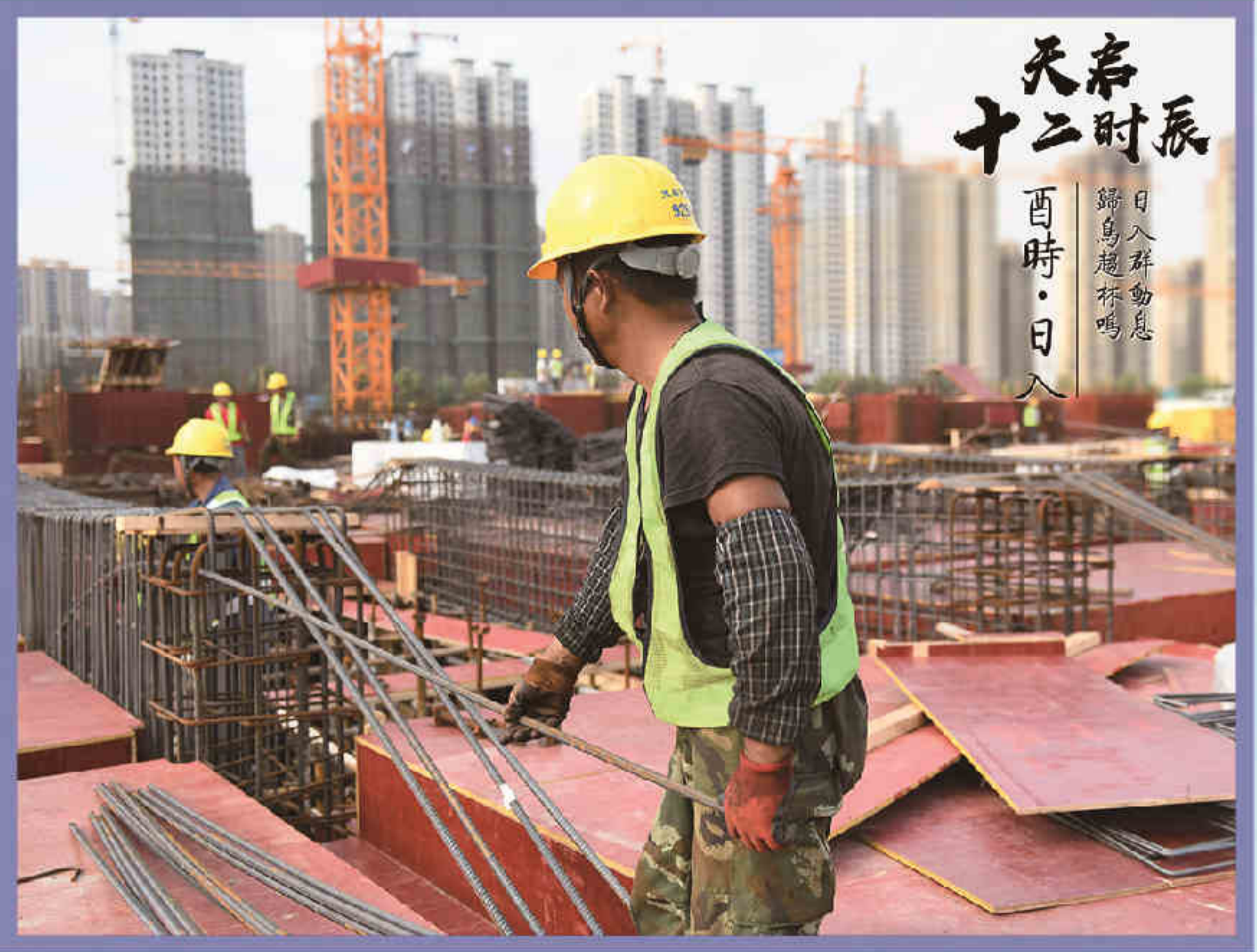
阳光西斜，偶尔吹来的凉风，没有吹散一丝“战场”上火热高涨的建设火焰，虽身躯疲惫，但背影坚毅，因为每一天都在缔结美好生活的希望。
